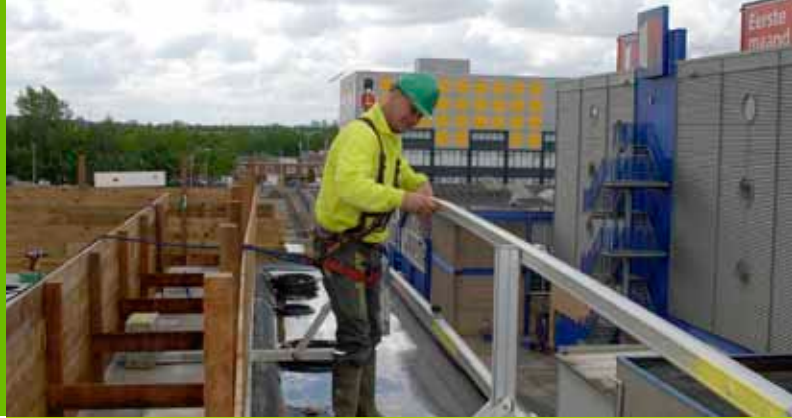
De grootste daktuin van Europa in aanbouw
